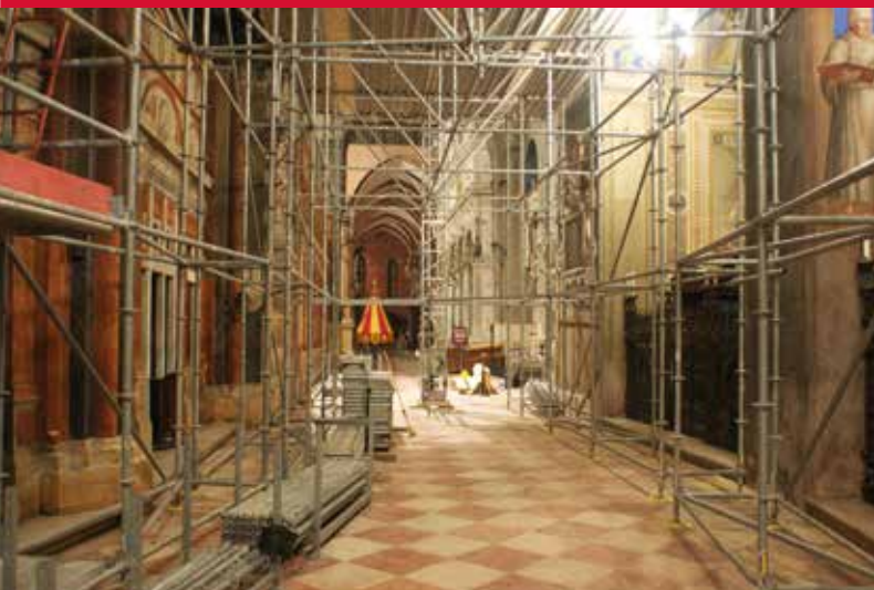
Ponteggi a servizio del restauro conservativo di edifici storici.
