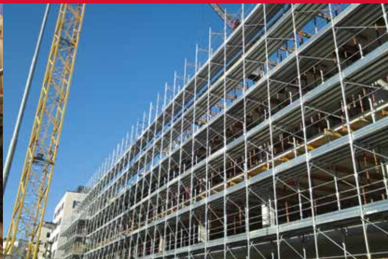
Ponteggi a servizio della manutenzione di edifici residenziali e commerciali, e a servizio di fabbricati di nuova costruzione.
